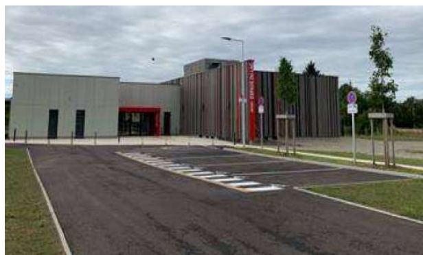
Salle familiale (2021) : construction d'une salle familiale sur le site de Bouvent-Curtafray. Bâtiment en simple RdC aux normes d'accessibilité
