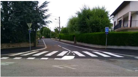
Rue des CEDRES (2020) : réfection des trottoirs, création d'un passage piétons
