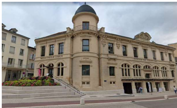
Médiathèque CAMUS et Office de Tourisme (2019) : réhabilitation lourde de ces 2 ERP avec une mise aux normes d'accessibilité complète et la création de 2 ascenseurs
