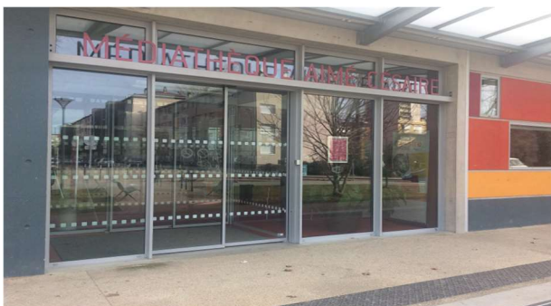
Médiathèque CESAIRE (2019) : mise aux normes du cheminement extérieur, des accès et des sanitaires, signalétique sur portes vitrées
