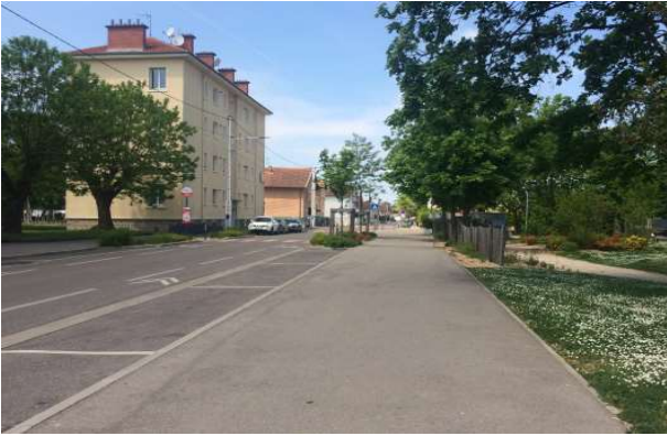
Rue MONTESQUIEU – section rue Molière à rue de la Chartreuse (2018 à 2021) : réaménagement complet – création d'une chaussée partagée, rénovation de la chaussée et des trottoirs, plantations
