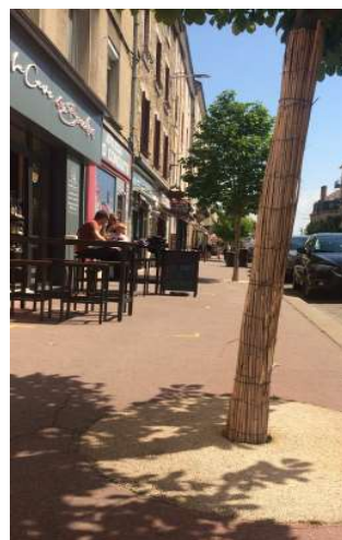
Pieds d'arbres – Av. A. BAUDIN (2020) : application d'un matériau drainant et non meuble pour combler les ruptures de niveaux
