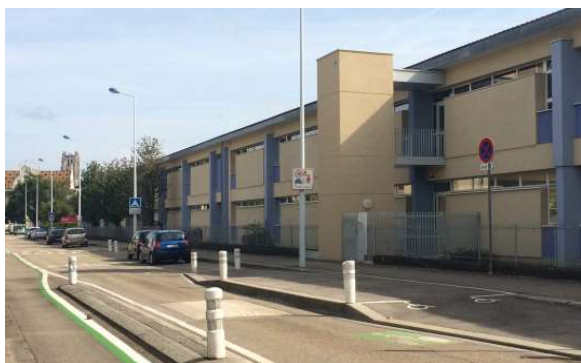
GS ARBELLES élémentaire : mise en accessibilité complète du site avec création d'un ascenseur – aménagements extérieurs (travaux 2018 finalisés en 2019)
