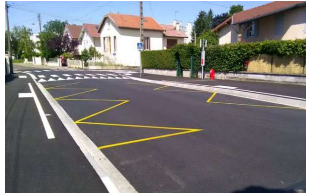
Rue des DIMES (2021) : création d'un plateau surélevé au carrefour de la rue des Joncs pour mises aux normes PMR de 3 traversées
