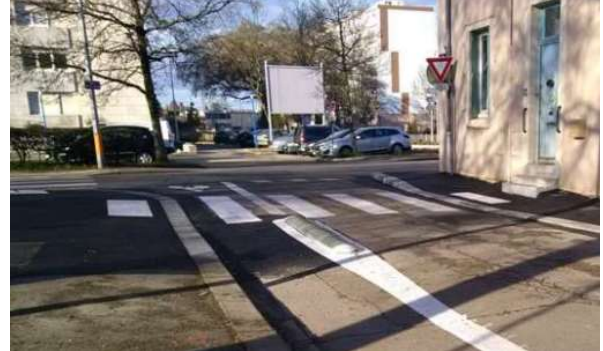
Rue Xavier PRIVAS – angle rue du Pont des Chèvres : création d'un passage-piétons (2020)
