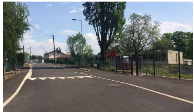
Rue Louise CHEVRIER (2021) : réfection chaussée et trottoirs, mise aux normes des passages-piétons, dispositifs de ralentissement
