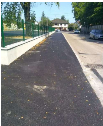
Rue des Compagnons (2021) : réfection de trottoir dégradé
