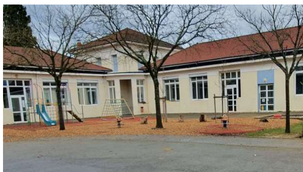
Groupe scolaire des Vennes (travaux 2020)
