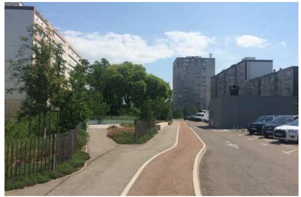
Edouard HERRIOT section Morgon/Pont des Chèvres (2019-2020) : réaménagement complet – suppression d'une voie de circulation au profit des piétons et des cycles, aménagements paysagers et de berges, création d'un belvédère, réfection des passerelles piétonnes
