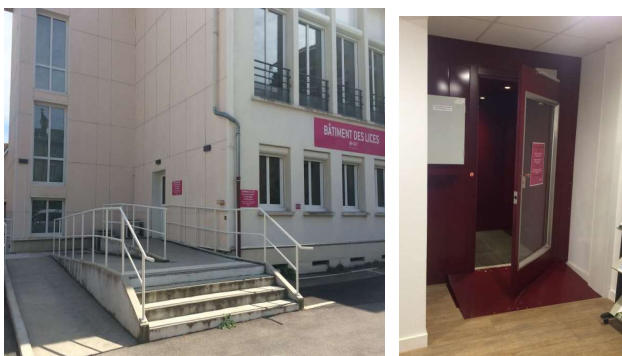
Bat des lices (2019) : réhabilitation du bâtiment pour reloger des services Mairie accueillant du public, en remplacement des anciennes résidences non ou peu conformes (centre Thérèse Sommier et Maison des associations). Création d'un ascenseur.
