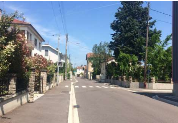
Rue MONTHOLON : réaménagement complet rue Comte de la Teyssonnière à avenue du Mail (2019-2020) : rénovation de la chaussée et des trottoirs, rétrécissement localisé de la chaussée, plantations
