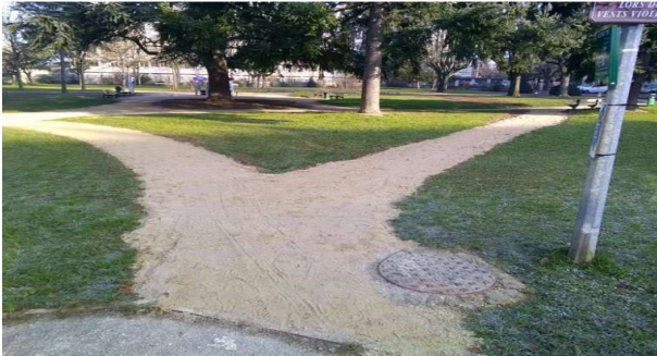
Square Louis Parant : aménagement de cheminements non meubles pour accéder à l'espace pique-nique (2020)
