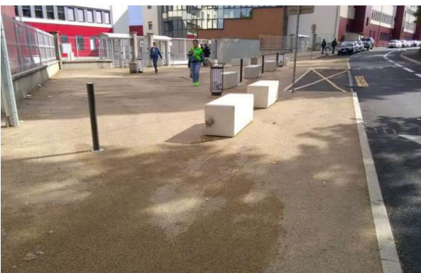
Rue de CROUY (2021) : réfection des trottoirs et de la chaussée, mise aux normes des GICs
