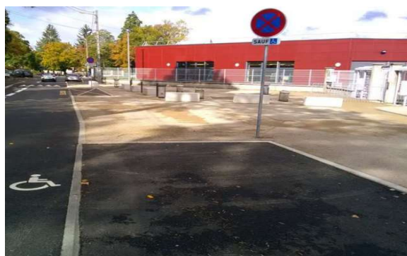
Rue de CROUY : mise aux normes des GICs devant le lycée Quinet dans le cadre des travaux de réfection de la rue (2021)
