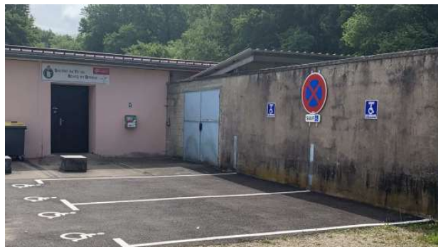
Stand de Tir (2021) : modification des portes, mise en place de rampes, places de stationnement GIC, aménagement des sanitaires et chemin d'accès
