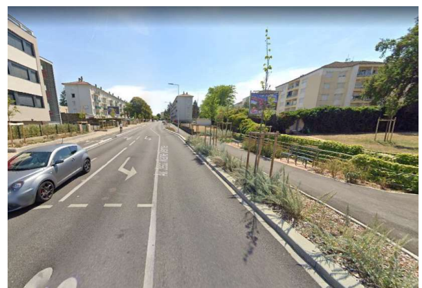
Jean Marie VERNE – de Rue de St Roch à place Perrier Labalme (2019 à 2021) : réfection des trottoirs et de la chaussée, création d'une piste cyclable bidirectionnelle, mise aux normes des quais bus (GBA), plantations
