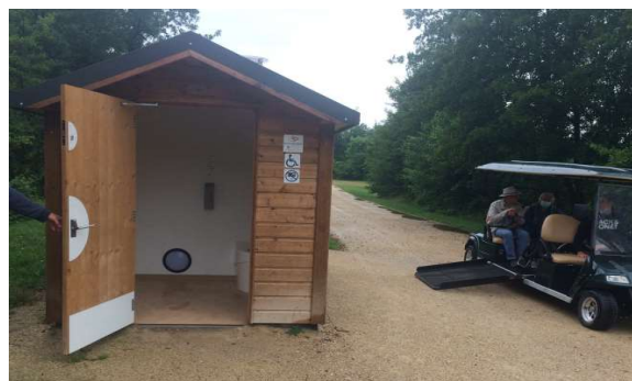
Installation de toilettes sèches adaptées le long du lac
