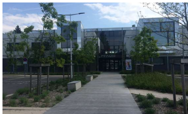
Maison de la Culture et de la Citoyenneté (2020) : construction d'un bâtiment en remplacement de ceux de la MJC et de l'AGLCA anciens et non conformes. Création d'un ascenseur
