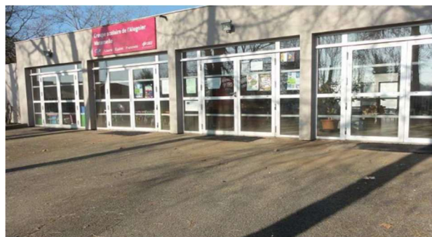
GS ALAGNIER maternelle (2019) : mise aux normes du cheminement extérieur, remplacement de portes intérieures
