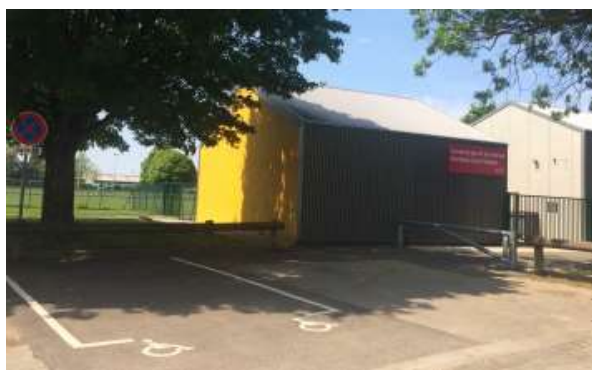
Vestiaires MOUTHIER – Gymnase des Vennes (2020) Réhabilitation de l'ancien vestiaire non conforme après incendie. Reconstruction des vestiaires, création d'une salle de convivialité
