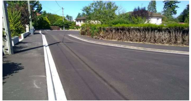
Rues Honoré d'URFE et MALHERBES (2019) : élargissement des trottoirs, création de passages piétons
