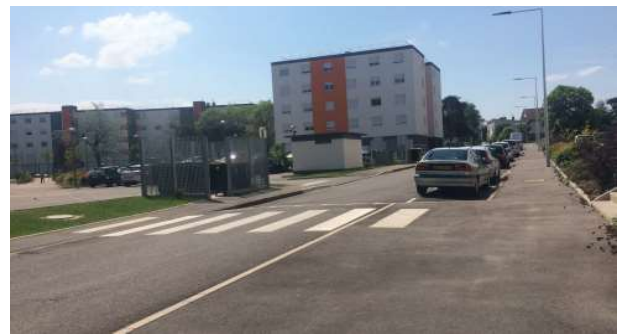
Rue des TULIPES (2020-2021) : réfection chaussée et trottoirs, création et mises aux normes de passages piétons, dispositifs de ralentissement
