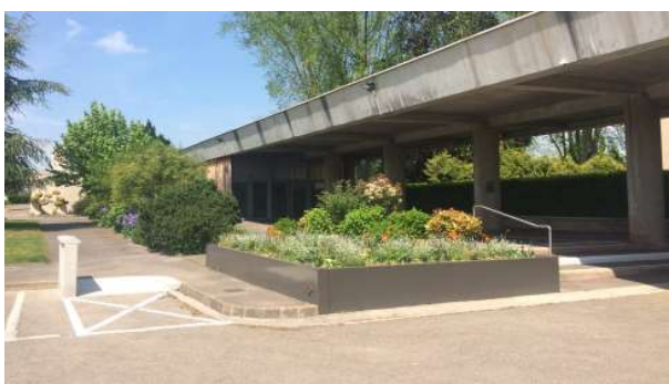
Salle municipale d'obsèques – abords (2021) : création d'une place PMR et d'une rampe d'accès, éclairage du cheminement extérieur, aménagement de bandes d'éveil à la vigilance.
