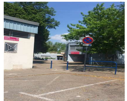
GS DAUDET : création d'un GIC et installation de barrières pour sécuriser les abords de l'école (2021)
