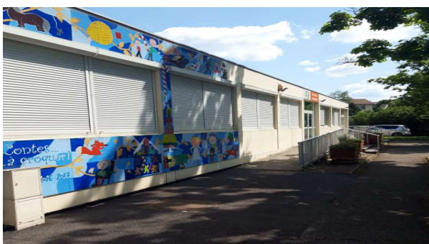
Epicerie solidaire (2020) : aménagement de la banque d'accueil, d'une rampe d'accès avec mains courantes et de bandes d'éveil à la vigilance
