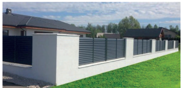
Exemple de clôture mixte présentant un mur bahut surmonté de claustras / brises-vues
