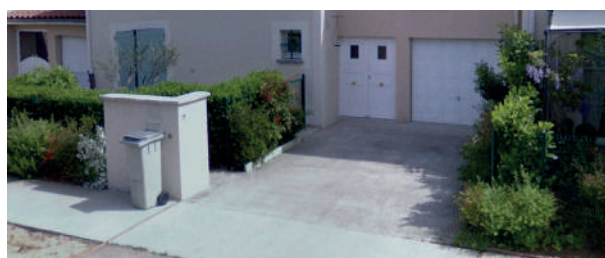
Exemple de traitement de clôture en retrait de la limite de lot
