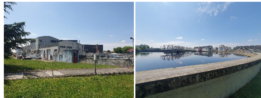
FIGURE 87 : STATION DE TRAITEMENTS DES EAUX USEES DE BOURG-EN-BRESSE-VIRIAT (SOURCE : EVEN CONSEIL)
