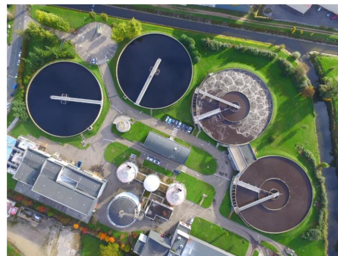
FIGURE 88 : STATION DE TRAITEMENTS DES EAUX USEES DE BOURG-EN-BRESSE-VIRIAT (SOURCE : BILAN DE FONCTIONNEMENT DU SYSTEME D'ASSAINISSEMENT DE BOURG-EN-BRESSE-VIRIAT, 2022)
