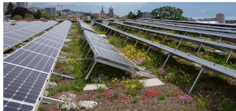
PRINCIPE D'AMENAGEMENT ET EXEMPLE D'UNE TOITURE BIOSOLAIRE (SOURCE SPADOM ET BENOIT RENEVEY)
